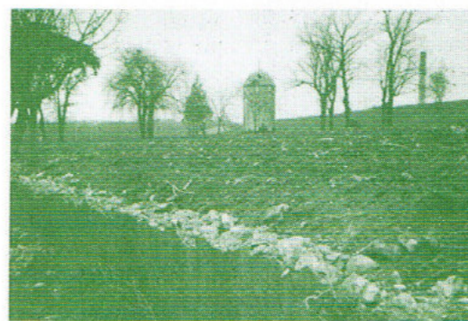
Travaux de réaménagement des abords de la cimenterie (Hiver 90-91)
